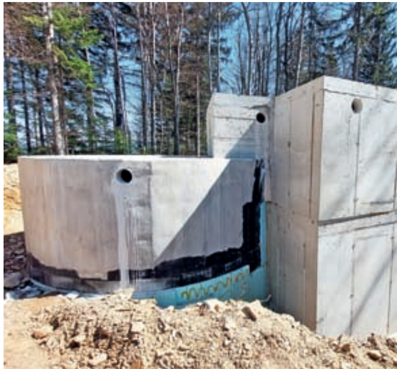
Na vodohranu Petelinov grič zaključujejo dela. FOTO: ARHIV OBČINE
